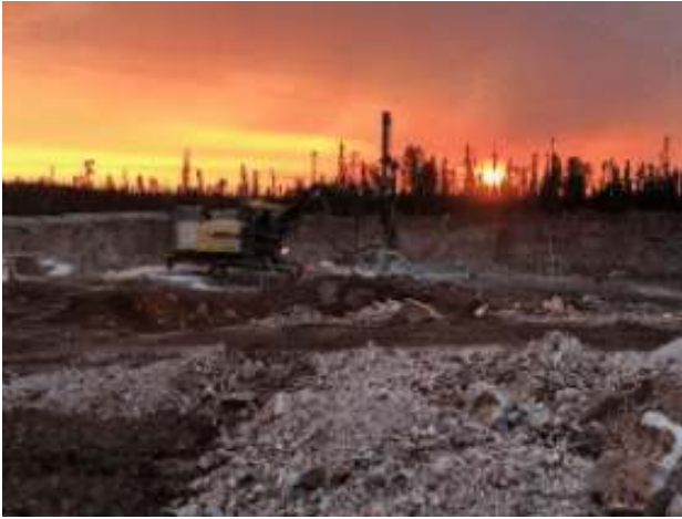
Night shift drilling
